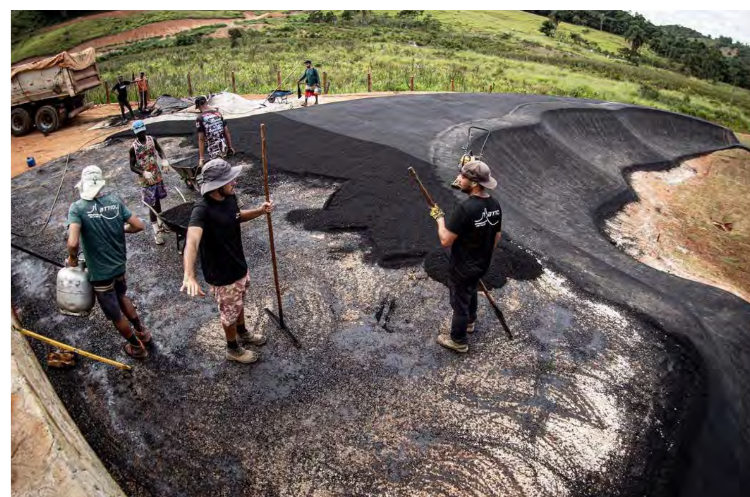
crédito: Mattioli Engenharia de Pistas / Bruno Sebastião
