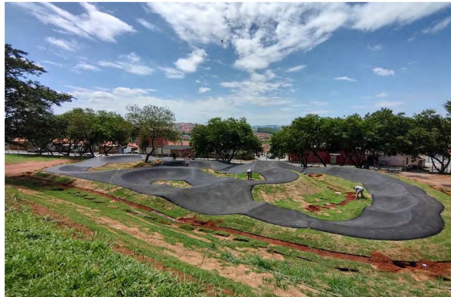
Finalização da pavimentação com CBUQ
