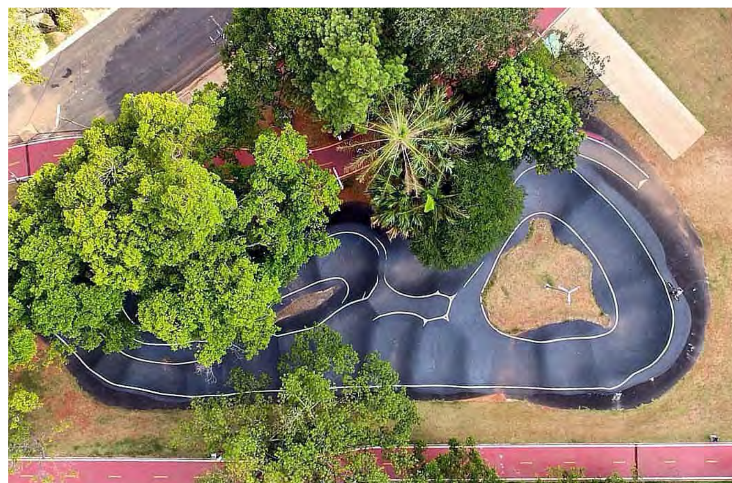
Pump Track do Centro de Esportes Radicais José Wilton Oliveira (Drac), no Bom Retiro, em São Paulo, SP
