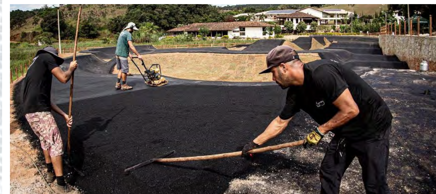
crédito: Mattioli Engenharia de Pistas / Bruno Sebastião
