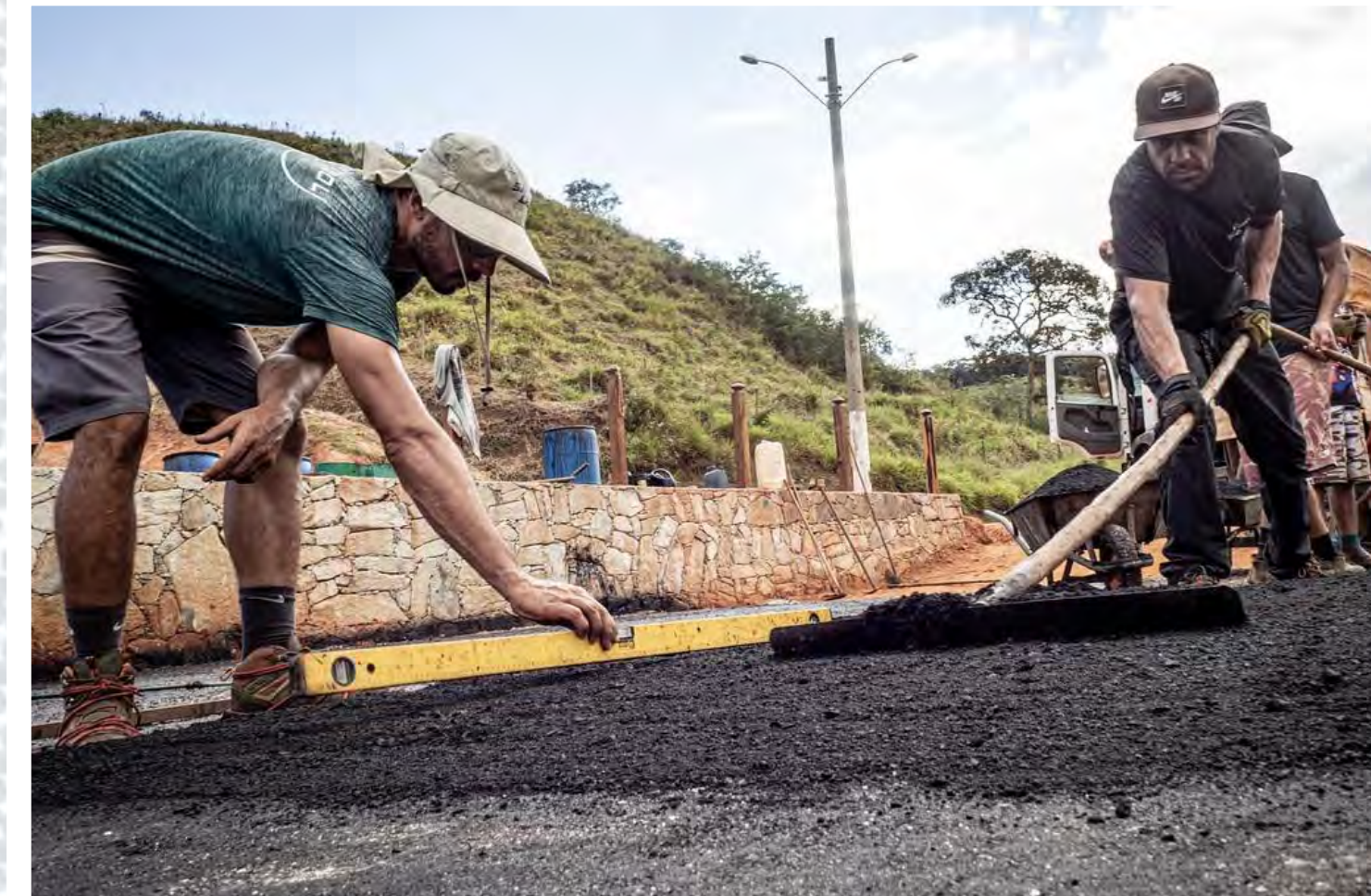
crédito: Mattioli Engenharia de Pistas / Bruno Sebastião
