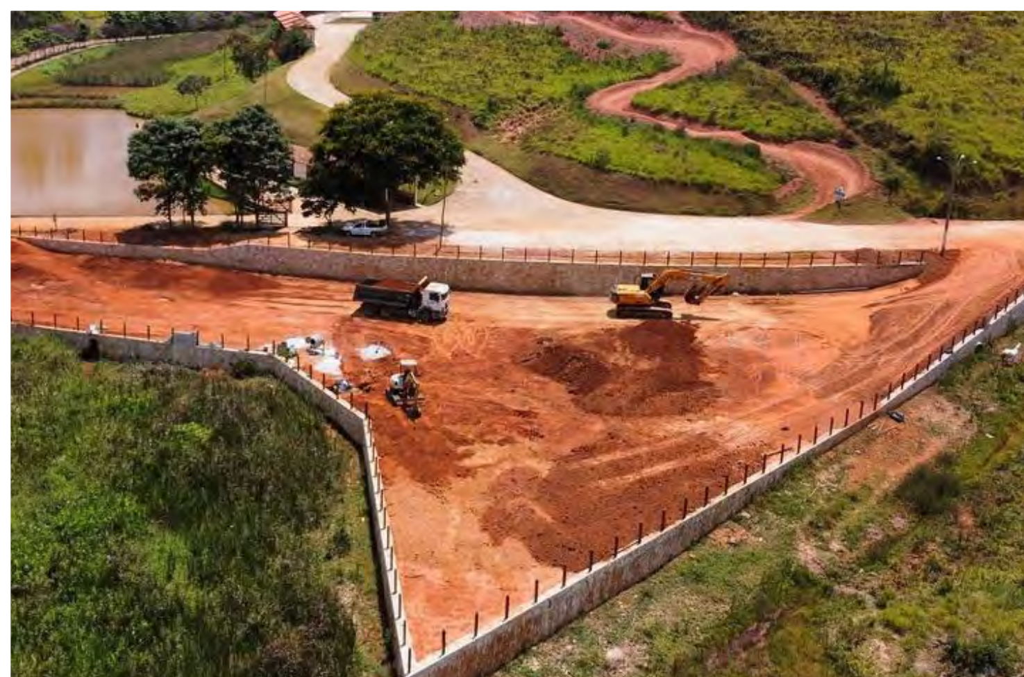
Limpeza e preparação do terreno.
