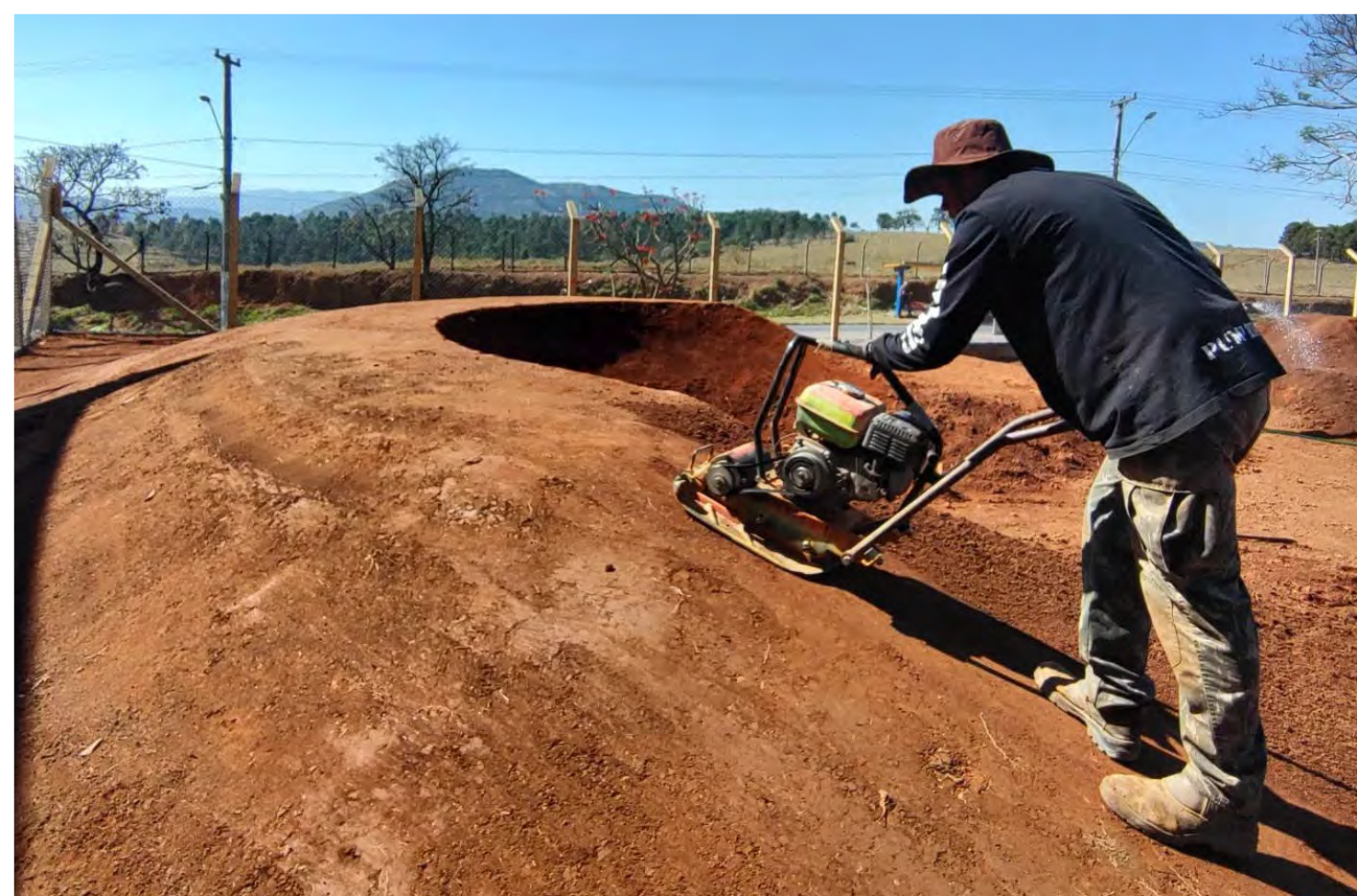
A chapa vibratória é utilizada para compactar os obstáculos esculpidos na terra
