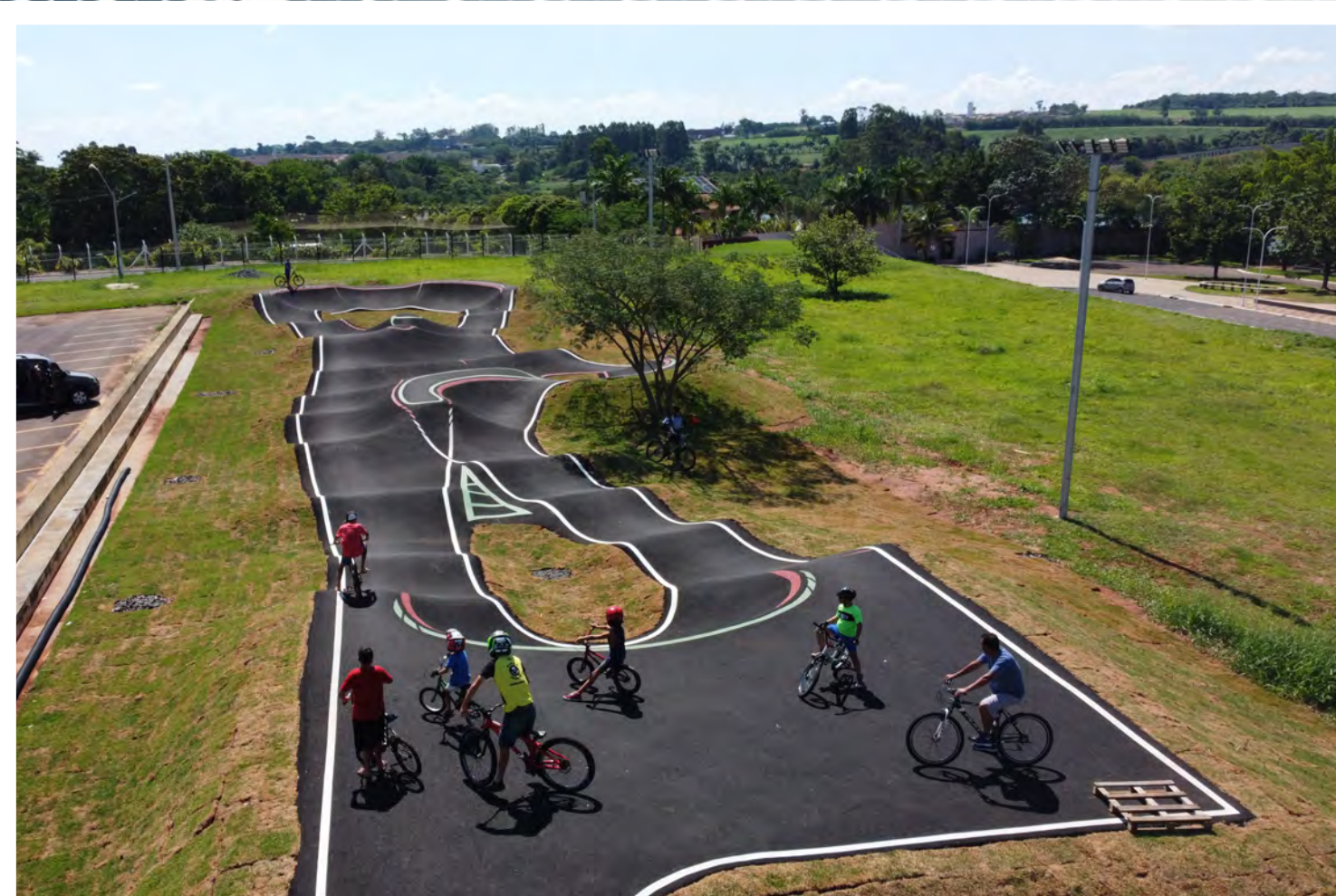
Aplicação da sinalização visual da pista
