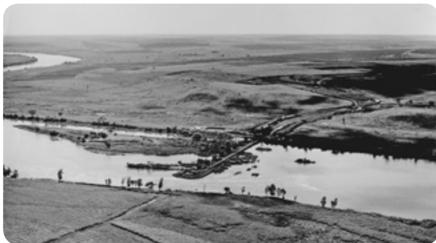
FOTO 1. Construção da usina hidrelétrica de Ilha Solteira em 1966
