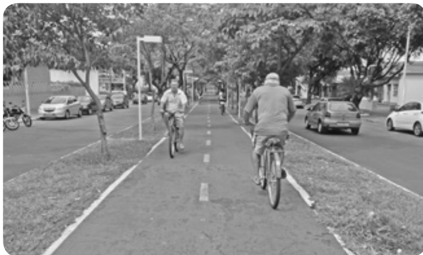
FOTO 7. Ciclovía da avenida Brasil (Norte e Sul)
